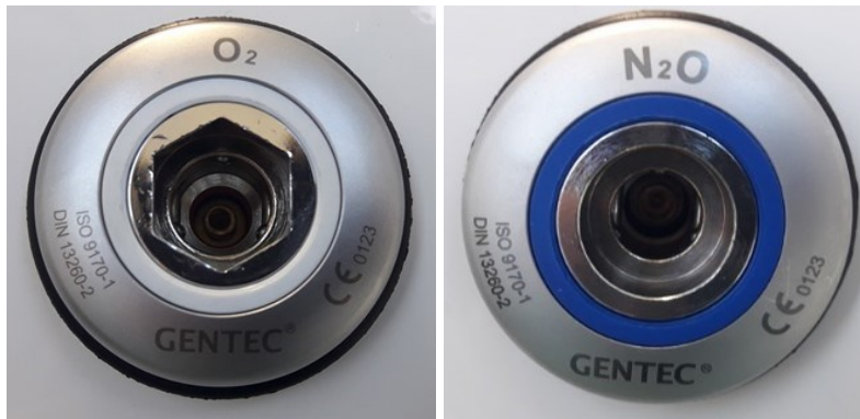
Slika 3: Končna spojka instalacij kisika (levo) in dušikovega oksidula (desno).
